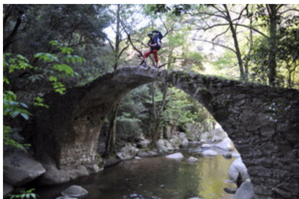
Genueserbrücke von Zaglia über den Tavulella
