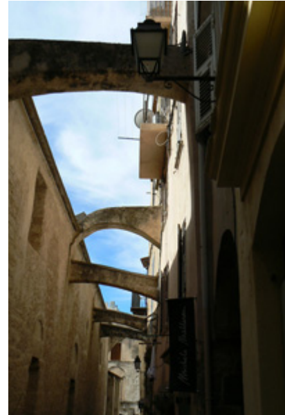
Die Bogen leiteten das Regenwasser in die Zisterne
