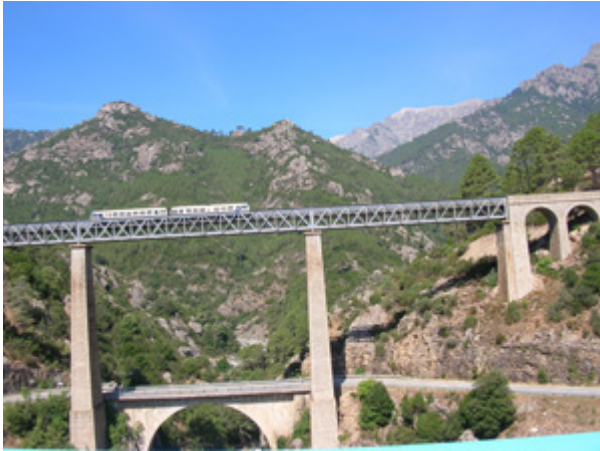
Ein Werk von Gustave Eiffel: Eisenbahnbrücke über den Vecchio
